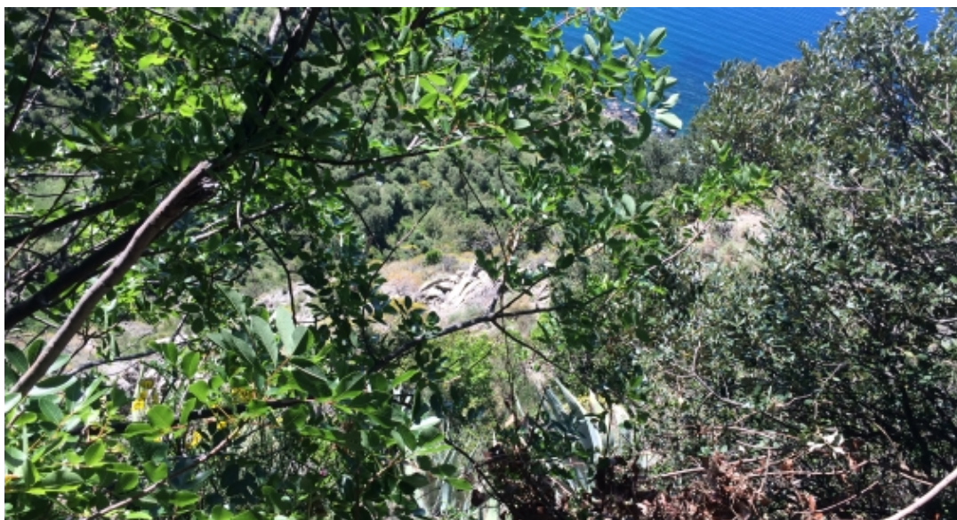
Area di Massolina, settore sub-verticale a ridosso del sentiero azzurro. Visibile tra la fitta vegetazione l'ammasso roccioso allentato e disarticolato.
