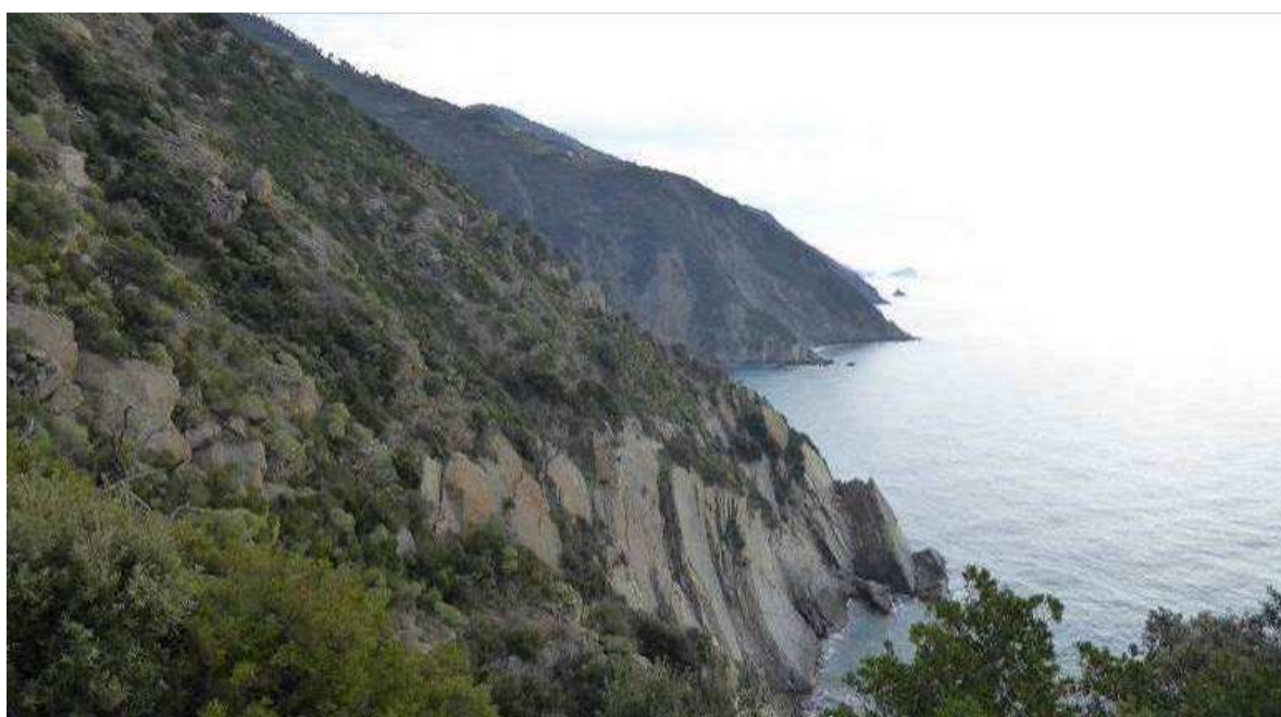
FIG.22: RIPRESA DI DETTAGLIO DELLA FALESIA ROCCIOSA (FONTE INTERNA).
