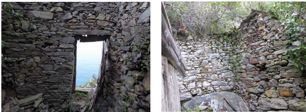
Fig.7 - 8: DETTAGLI INTERNI DEL FABBRICATO RURALE OGGETTO DI VALUTAZIONE (FONTE INTERNA).
