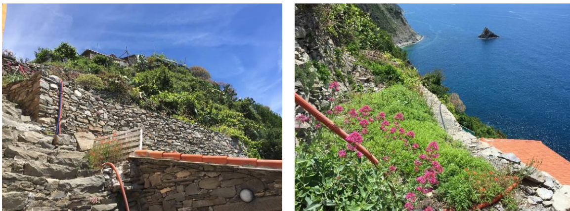
Fig.13 - 14: RIPRESE DEL CESPITE OGGETTO DI ANALISI (FONTE INTERNA).
