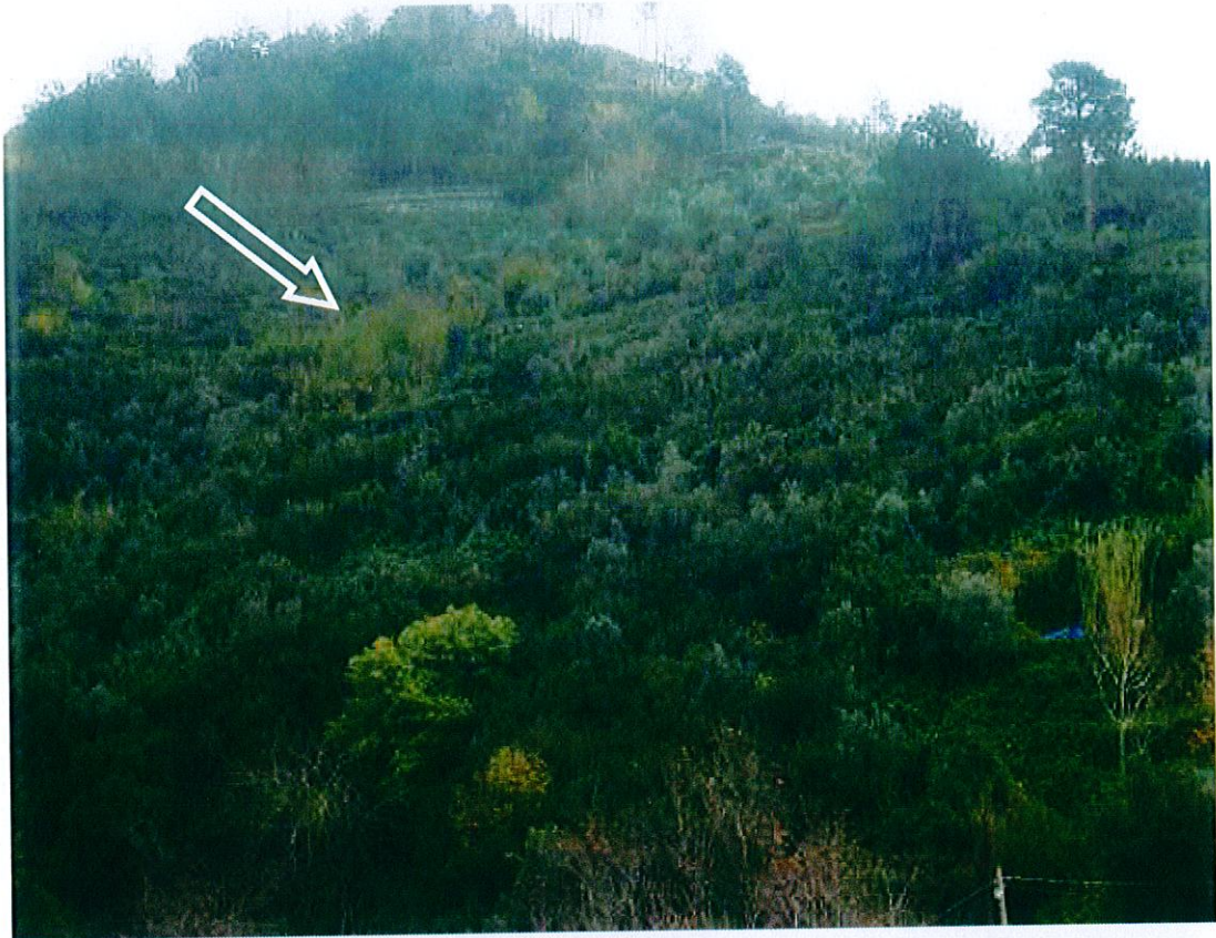
FIG.3: RIPRESA DEL VERSANTE SUI CUI INSISTONO GLI IMMOBILI OGGETTO DI ANALISI.
