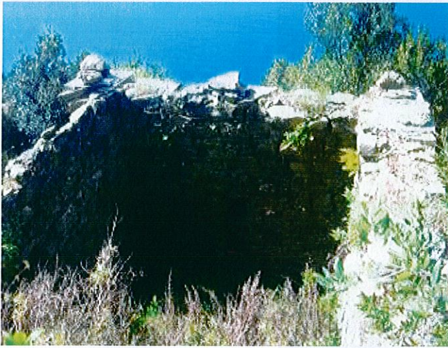
FIG.23: RIPRESA DI DETTAGLIO DEL FABBRICATO INDAGATO.
