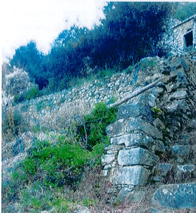
Fig.11: RIPRESA DI DETTAGLIO DEL FABBRICATO INDAGATO.
